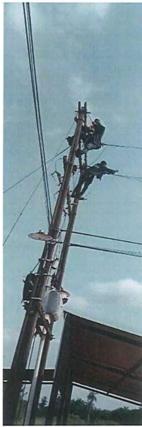
Durante el Mantenimiento
