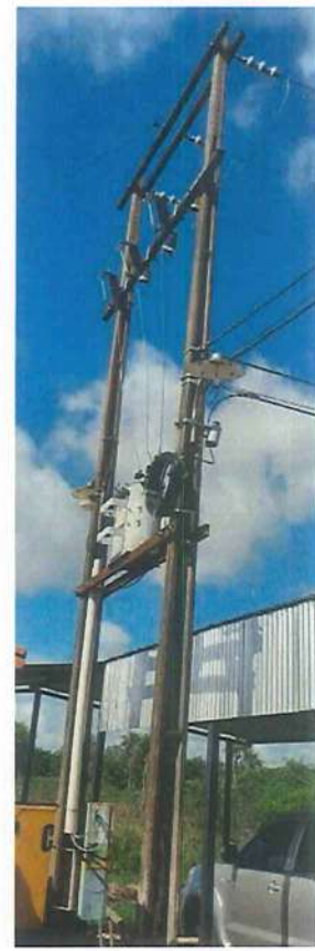
Después del Mantenimiento
